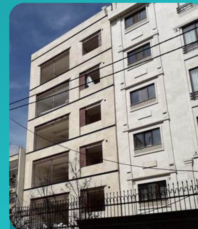
ساختمان مسکونی گیشا
