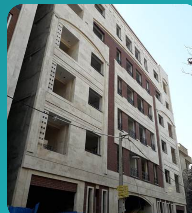
ساختمان مسکونی بلوار ارتش
