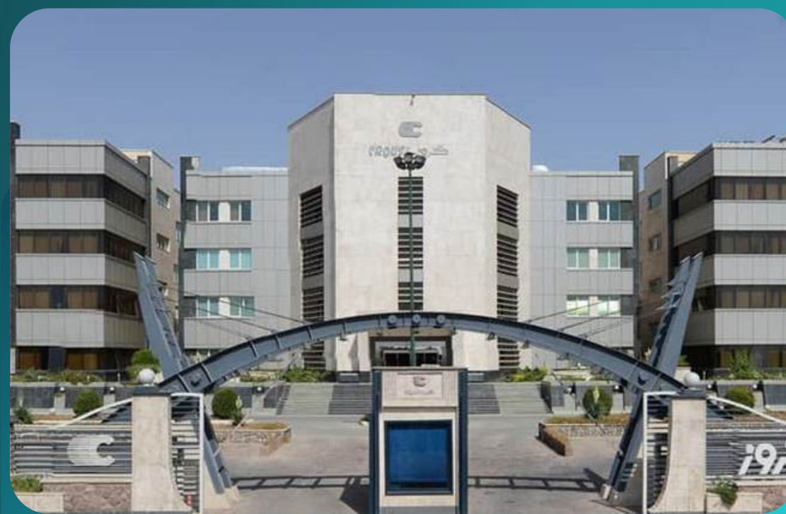
ساختمان اداری شرکت کروز
