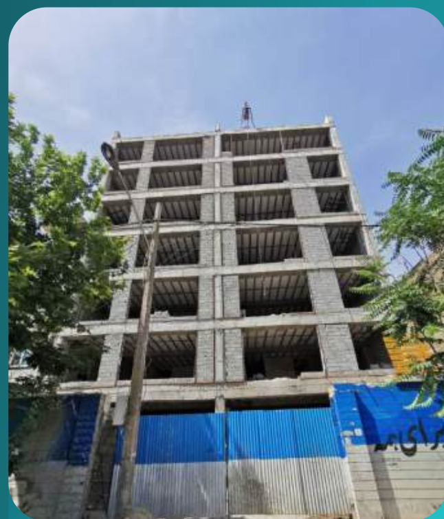
ساختمان مسکونی جنت آباد
