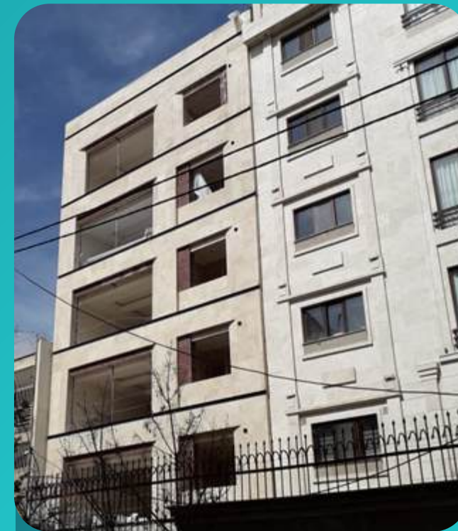
ساختمان مسکونی گیشا
