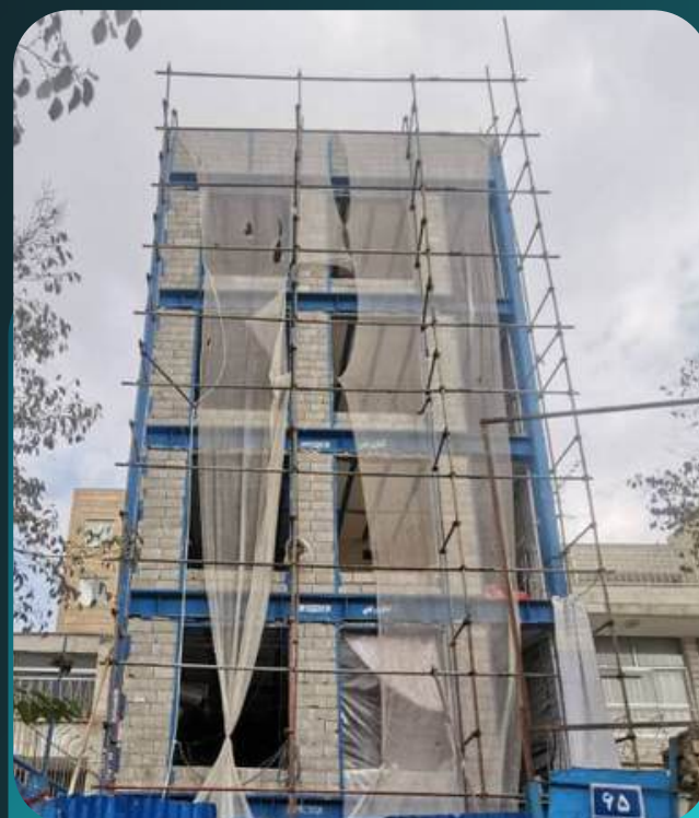
ساختمان مسکونی محلاتی
